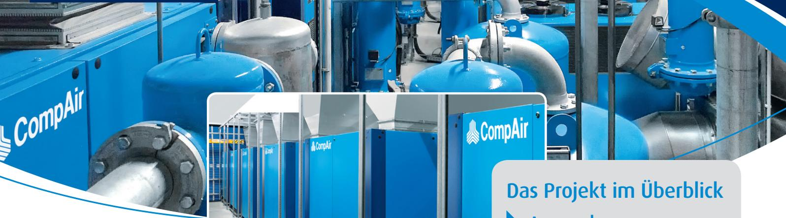
Die sechs CompAir-Schraubenkompressoren vom Typ L250 im BORBET Werk Kodersdorf. Mit einer Gesamt-Antriebsleistung von 1500 kW arbeiten sie außerordentlich energiesparend.
