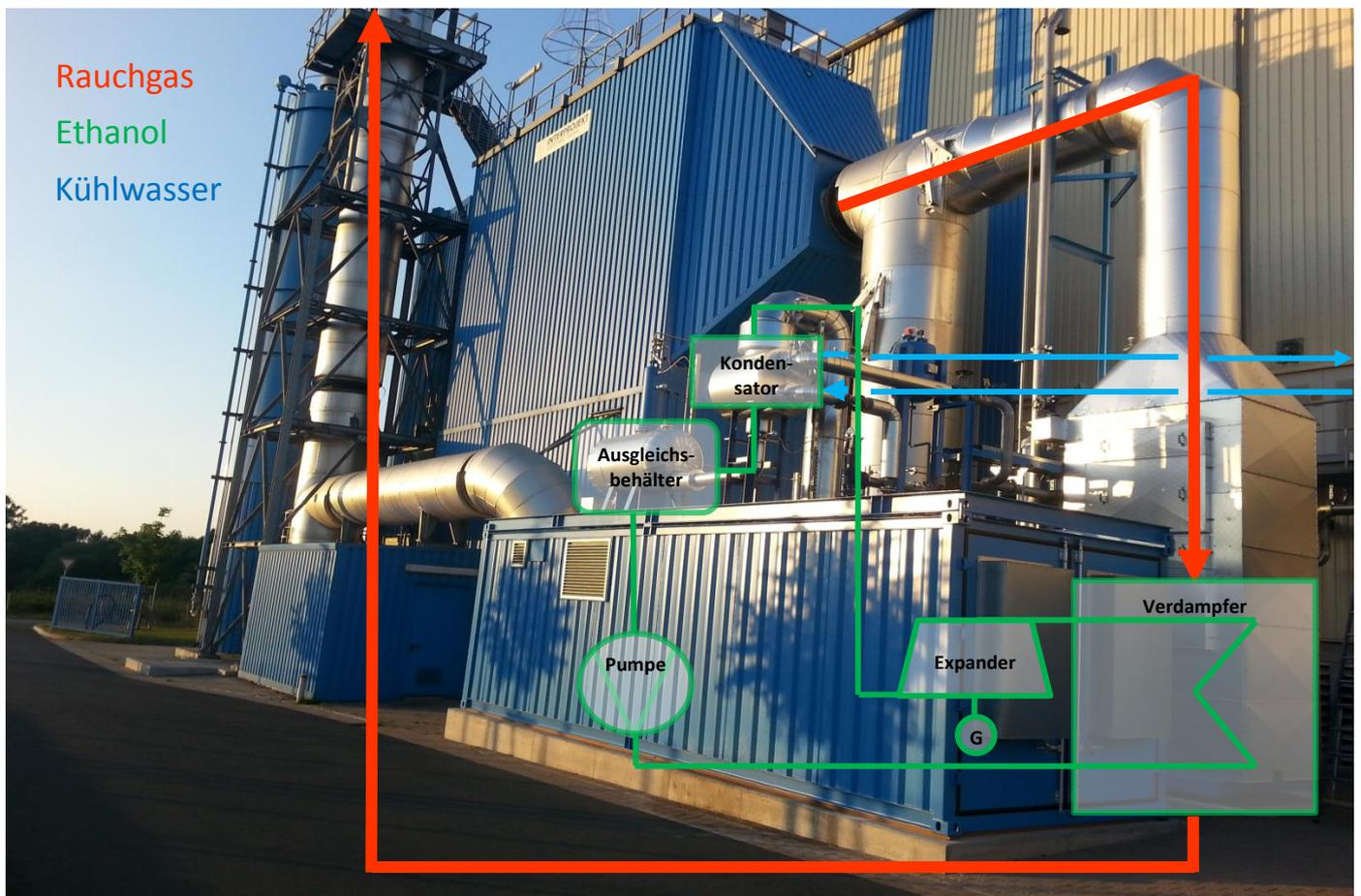
Abbildung 1: Aufbau und Funktionsweise eines Abwärmekraftwerks bei einer Anwendung in der Glasindustrie
