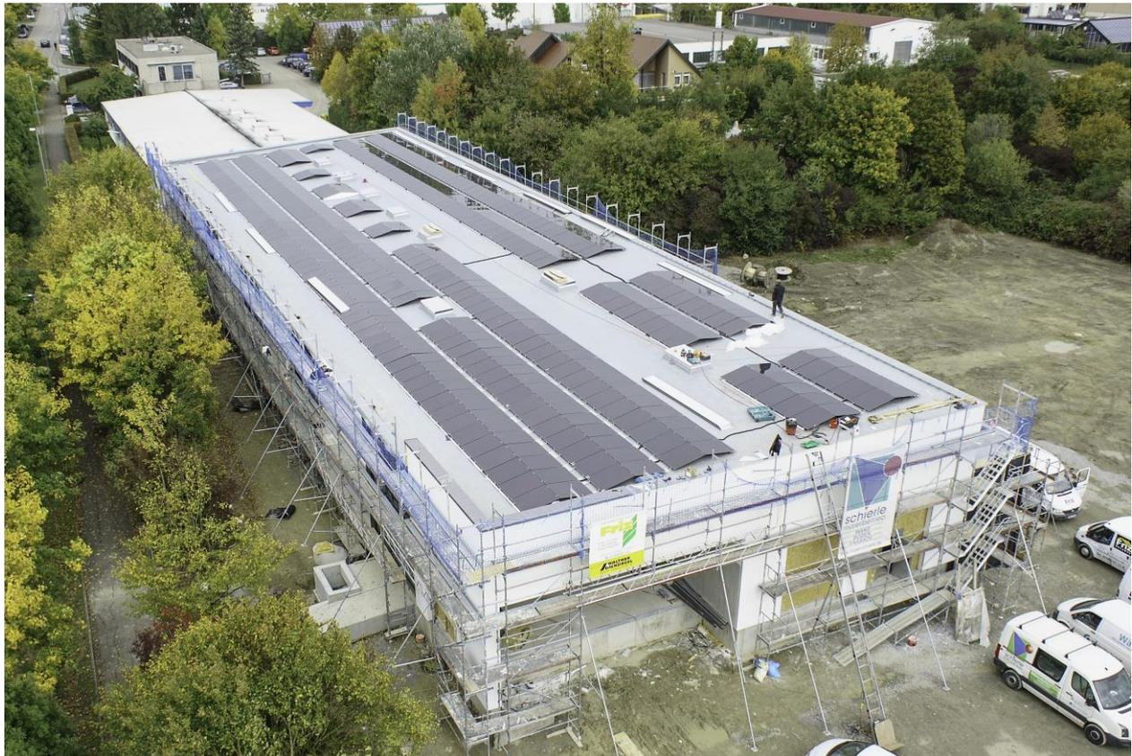
*PV-Anlage mit 60 kWp auf dem Dach der neuen Produktionshalle von ZIEHL industrie-elektronik*
