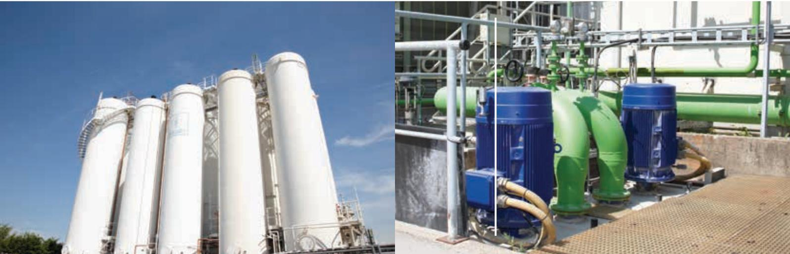
Die von der KSB Service GmbH durchgeführten Messungen ergaben, dass die Rohrgehäusepumpen im Kühlwasserkreislauf angesichts des tatsächlichen Lastkollektivs deutlich überdimensioniert waren. Auf der Suche nach einem energieoptimierten Ersatz für die beiden alten Pumpen führten die Ingenieure von KSB einen Vergleich zwischen mehreren Ausführungen von vertikalen Spiralgehäusepumpen durch.
