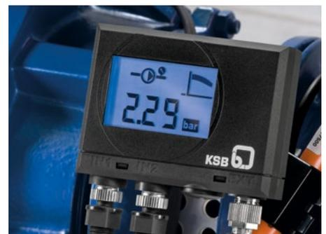
Erfassung der Betriebsdaten durch die Pumpenüberwachungseinheit PumpMeter
