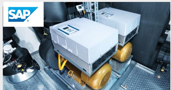
Smarte Aggregate von KSB sichern die Kühlmittelversorgung im Rechenzentrum.
